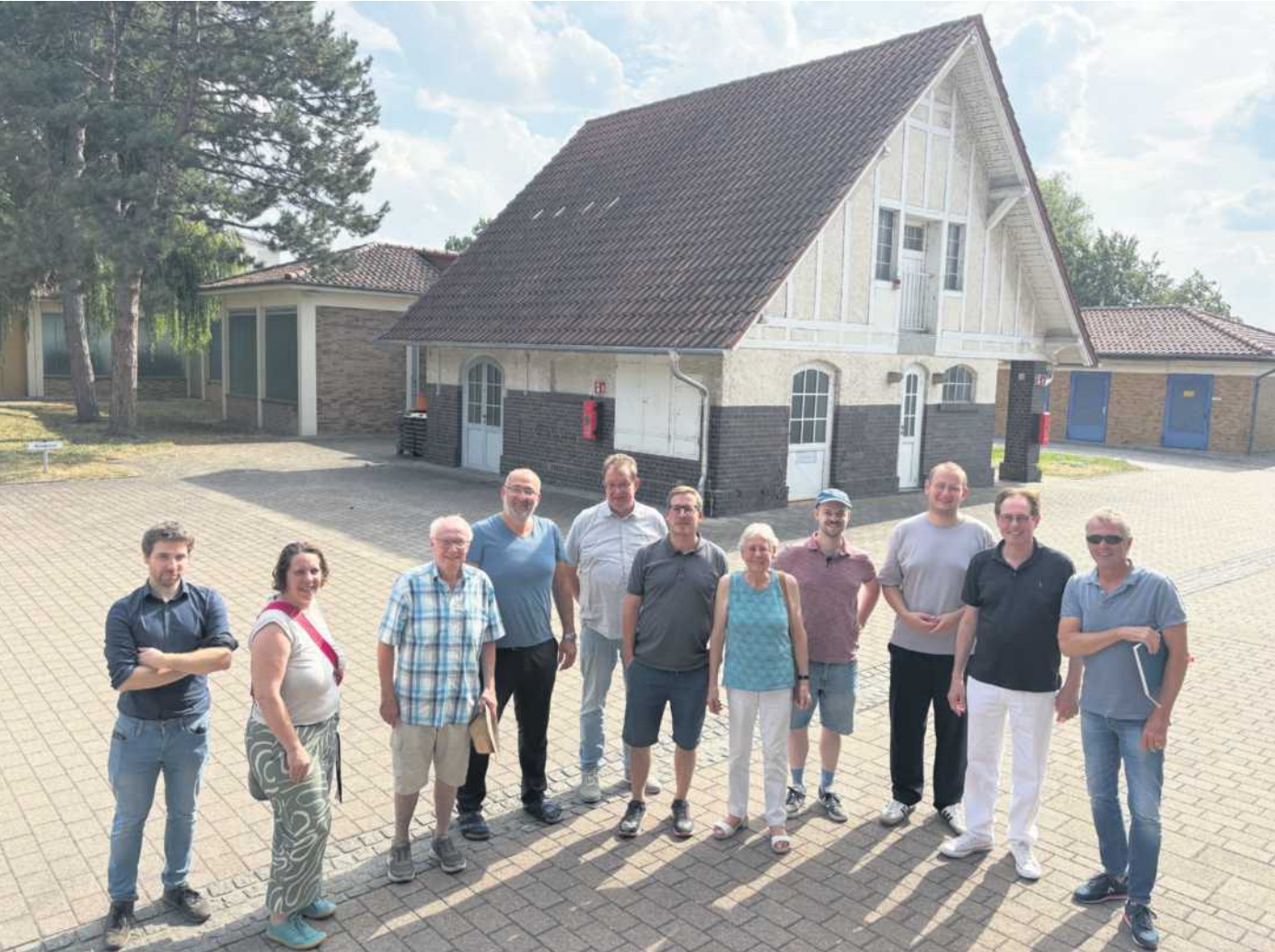
Rund um das Lebensmittel Nummer 1 ging es beim Betriebsbesuch der SPD Osthofen im Wasserwerk. Foto: Ronald Schmitt
