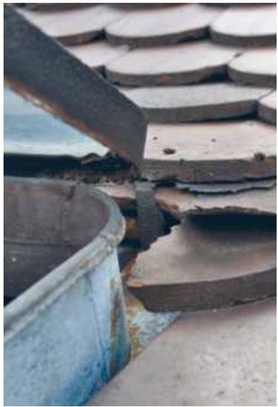
Thomas Neubecker und sein Team stehen als kompetente Ansprechpartner für Aufträge rund ums Dach zur Verfügung.
