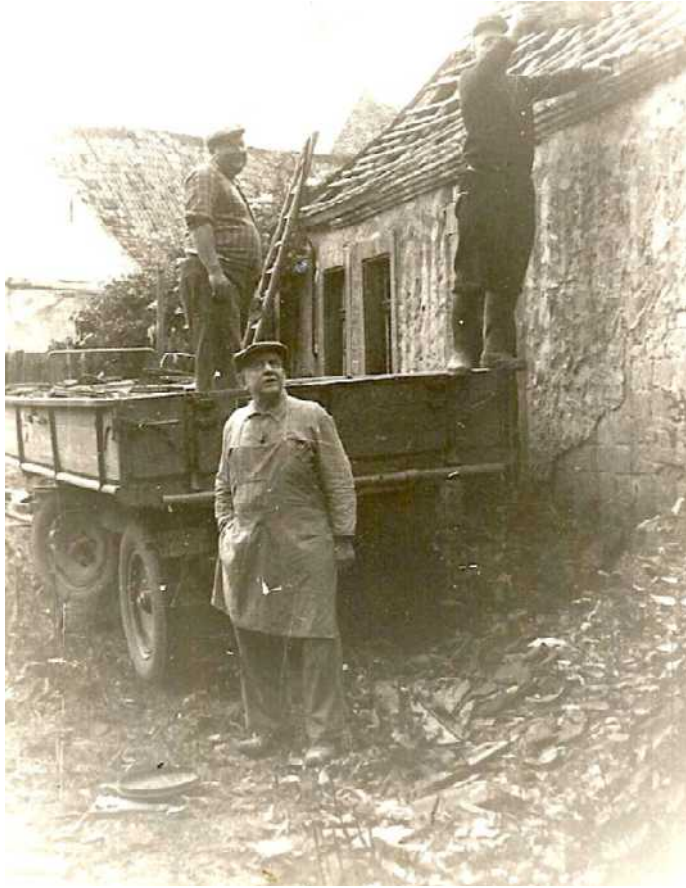
In der Bildmitte ist Schreinermeister Gregor Büttler, der Vater des Autors, bei Abbrucharbeiten zu sehen. Foto: Museum Abenheim
