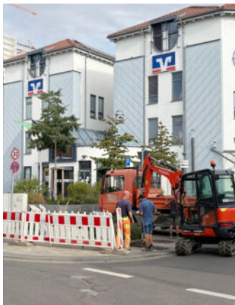
Hier im Herzen der Wonnegaumetropole soll der öffentliche Trinkwasserbrunnen entstehen.
