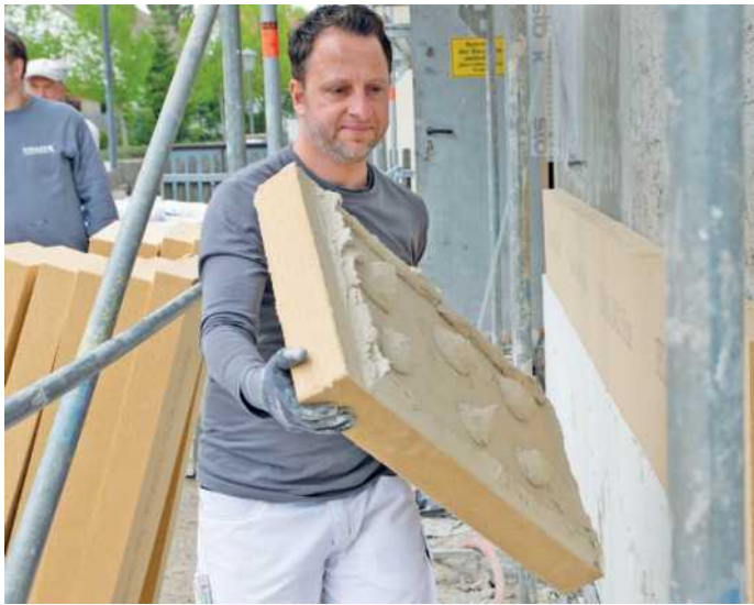
Aus alt wird neu – Holzfaser-Wärmedämmverbundsysteme an der Fassade, für gute Dämmwerte und wirkungsvollen Klimaschutz. Foto: steico.com/akz-o
