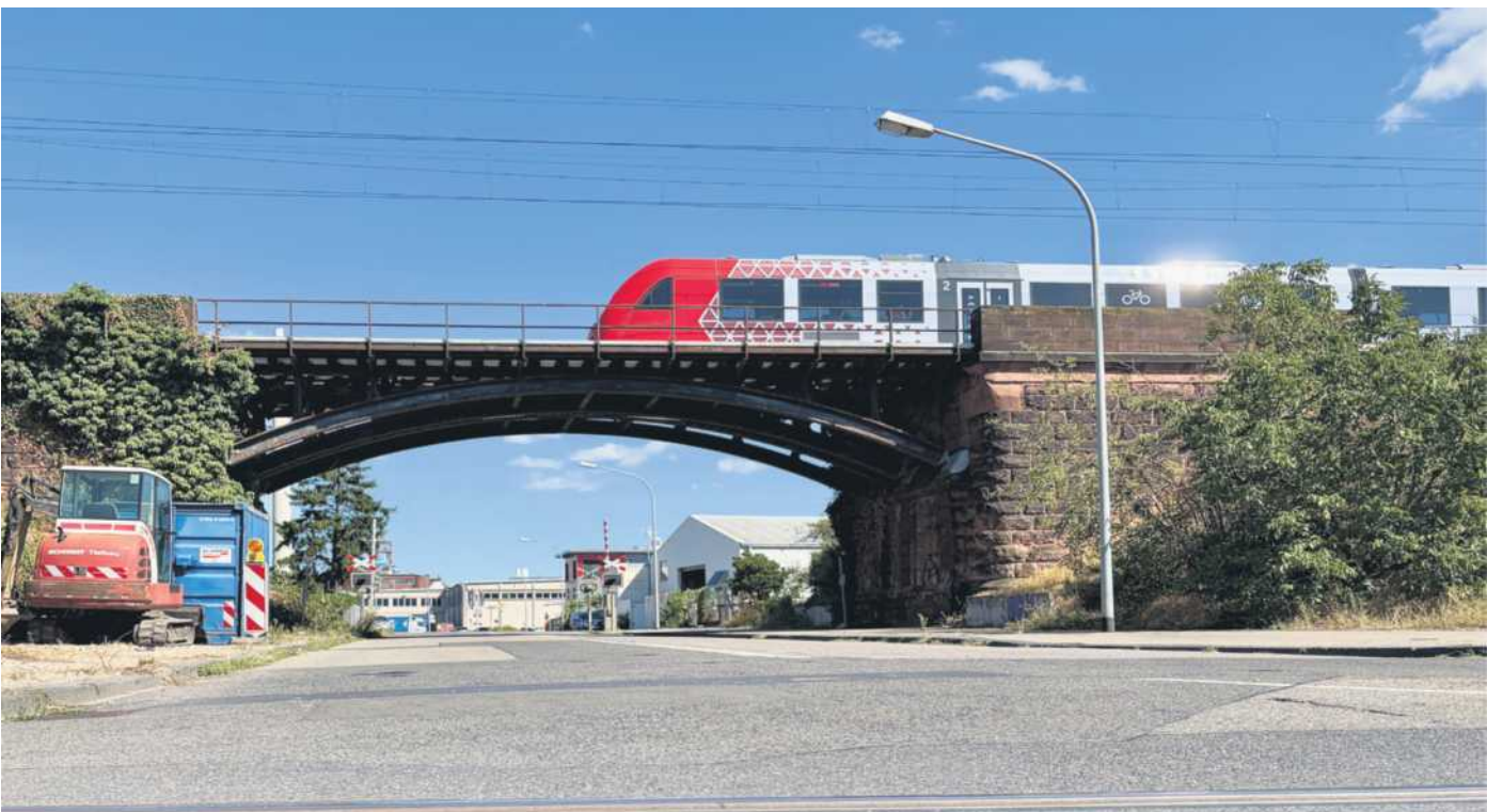
HAFENSTRASSE: EWR erneuert Leitungen vor Bahnarbeiten ab 10. August
