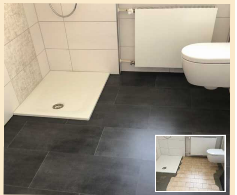
Die Mineral-Design-Böden können ohne Abbrucharbeiten direkt auf den Fliesen angebracht werden – wie hier auf den Vorher/Nachher-Bildern.
