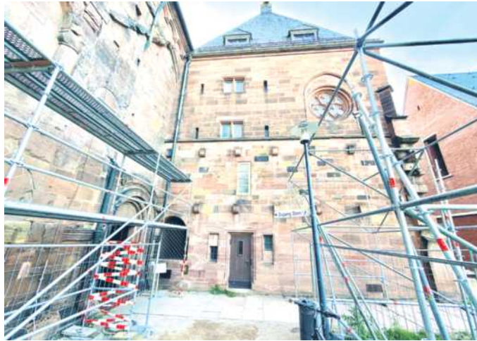
Die Seite zum Kreuzgang hin wird derzeit eingerüstet.
