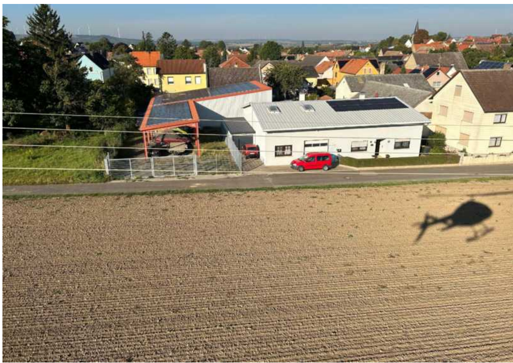
Die Inspektion aus der Luft ermöglicht EWR einen besonders guten Blick auf Leitungen, Masten und technische Bauteile. Foto: EWR
