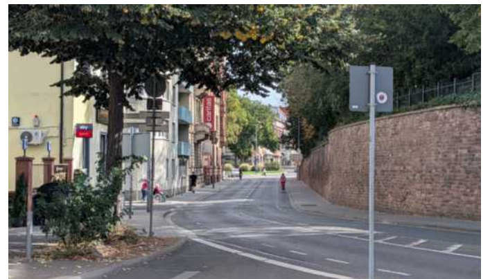
Zwischen Lutherring und Brunhildenbrücke soll der Streckenabschnitt erneuert werden.
